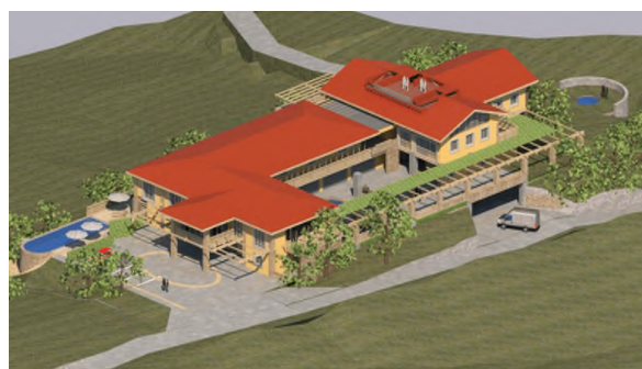
pogled s jugovzhoda
